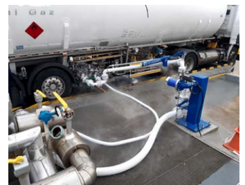
LNG Loading arm
